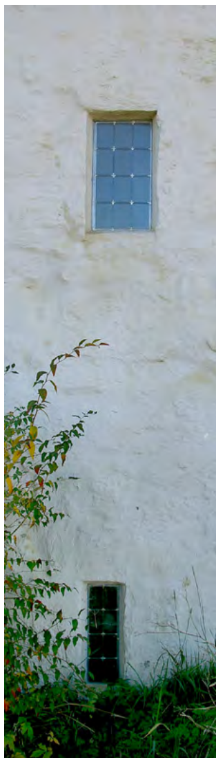
Den östra fasaden har från början endast haft tre små fönstergluggar. Här ses de två in till trapprummet ner till källaren.
