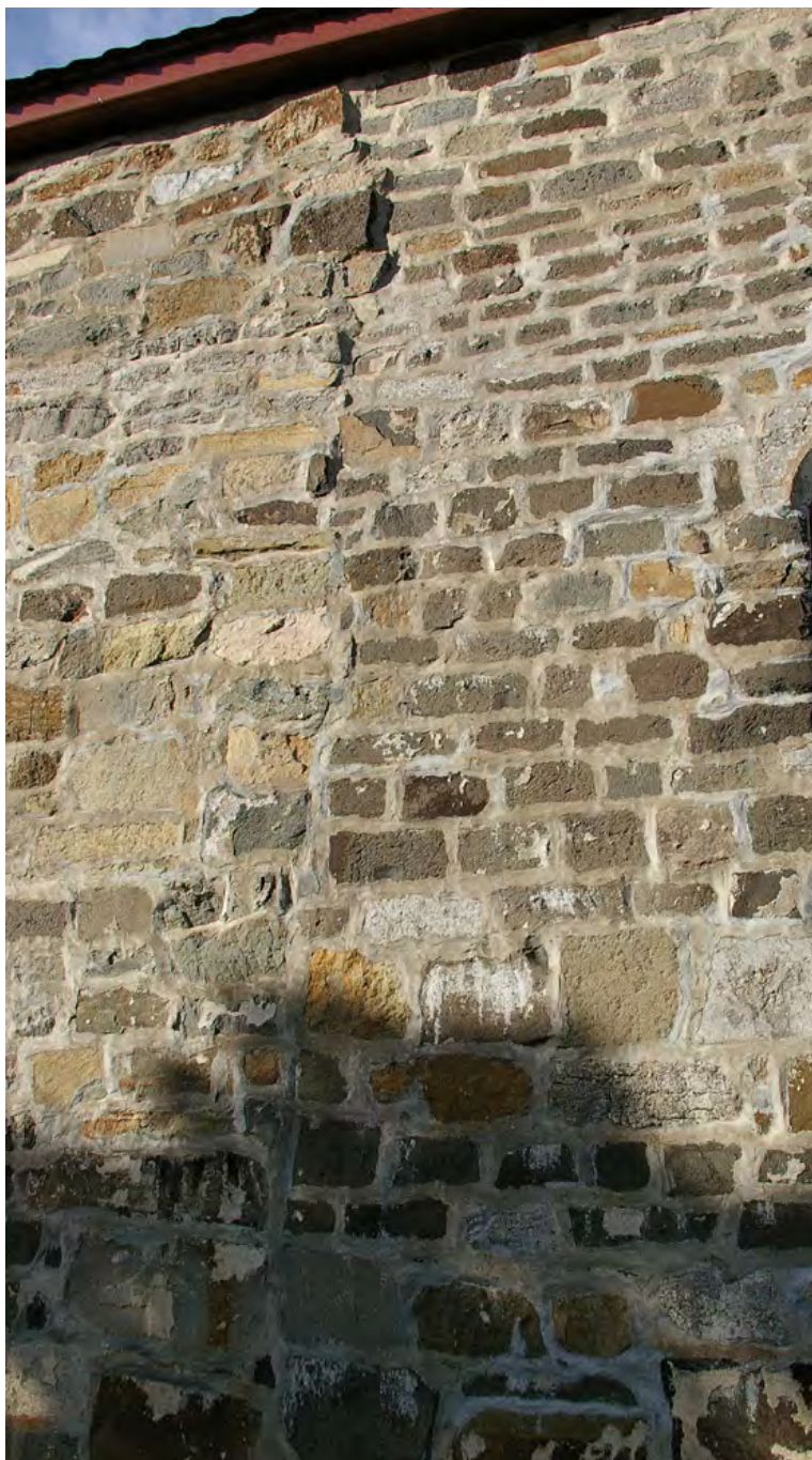
Stötfogen i Mariakyrkans södra långsida. Muren till vänster tillhör byggnadsperiod 3, till höger byggnadsperiod 4.
