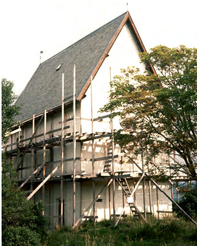
Steinhuset sett från sydost vid restaureringen sommaren 1973.
