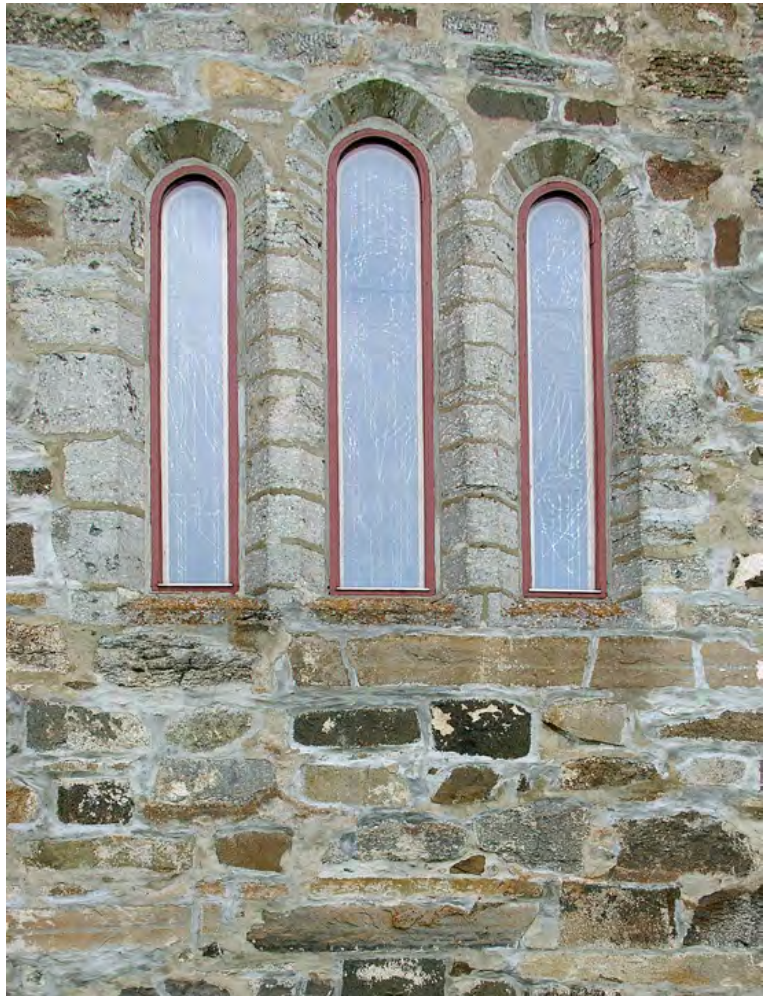
Till vänster: Den kyrkliga byggnadsverksamheten koncentreras under perioden till att utvidga de båda kyrkornas kor. Här ses Mariakyrkans östra korfönster.
