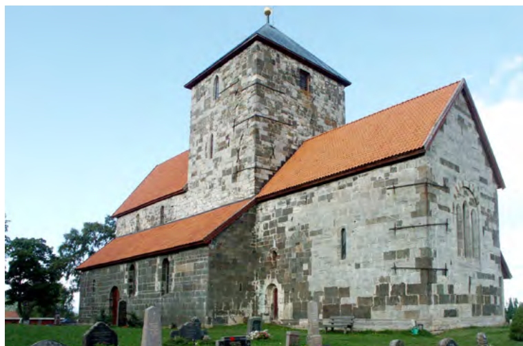
Nicolaikyrkan från sydost. Notera skillnaderna i koret mellan den yngre ljusa stenen och den äldre mörka.
